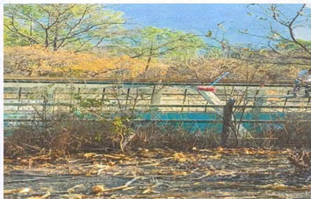
Foto 2: SE ESTA MEJORANDO EL TECHO CON LAMINA TROQUELADA.
