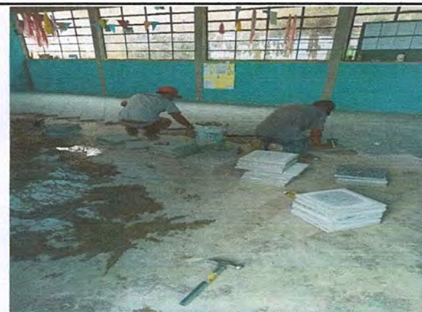
Foto 4: EL PISO DE LA ESCUELA SE ESTA CAMBIANDO POR PISO DE GRANITO
