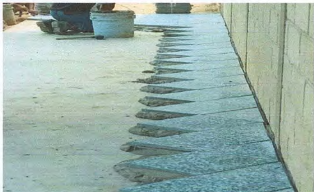
Foto 1: SE REESTABLECE EL PISO DE AFUERA DE LA ESCUELA.
